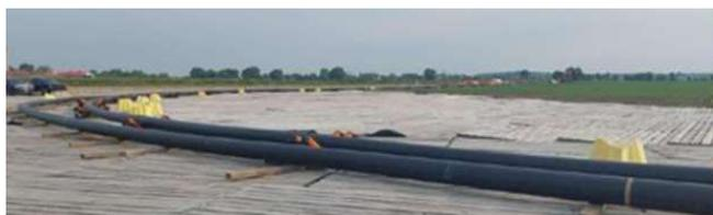
Le tirage des conduits se déroulera en deux étapes qui dureront de 10 à 12 heures chacune. Chaque étape doit se poursuivre jusqu'à ce que le conduit soit complètement inséré. Ceci est nécessaire pour éviter des complications techniques qui pourraient compromettre les travaux précédents.
