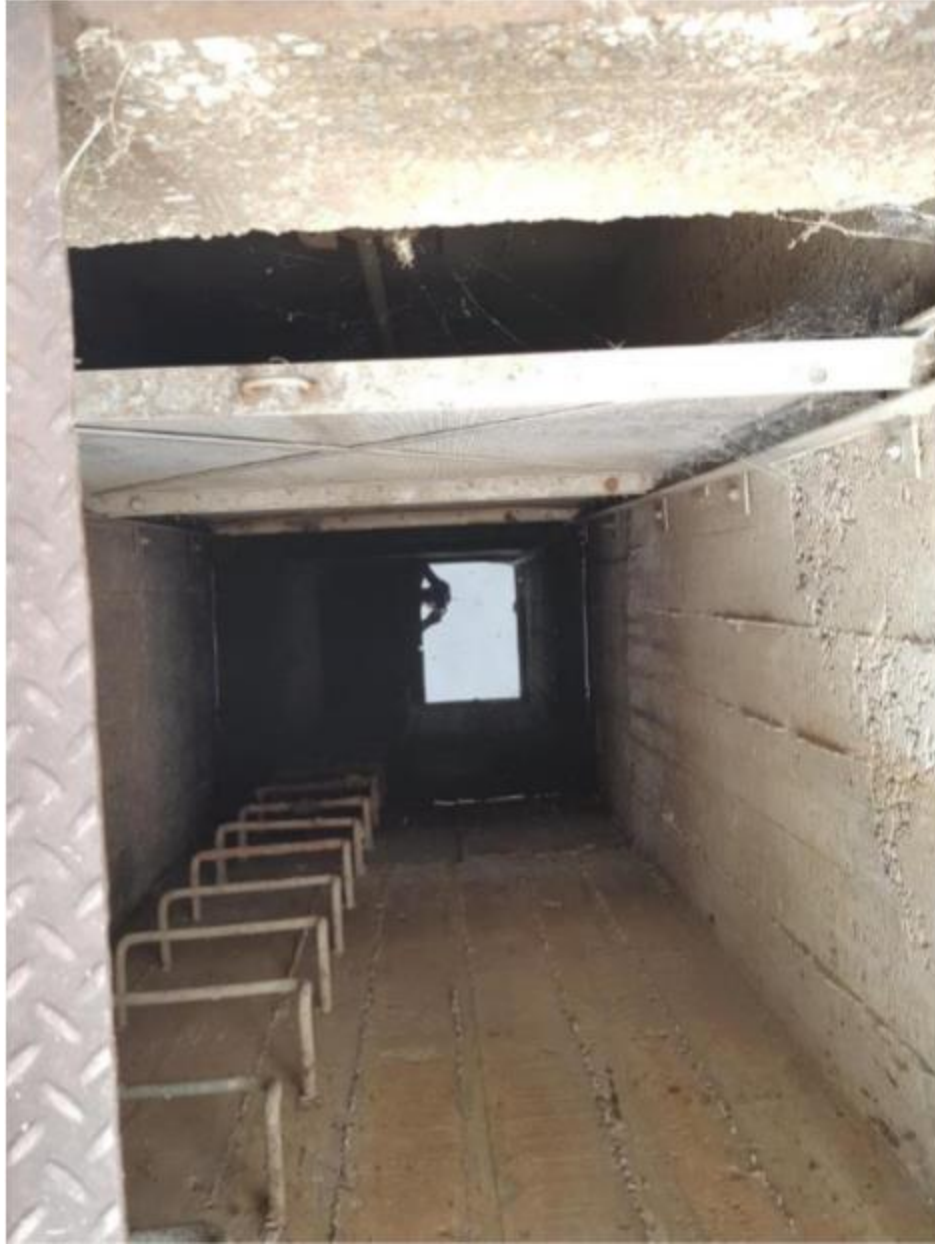
Puits des grilles de la conduite 1070 mm
