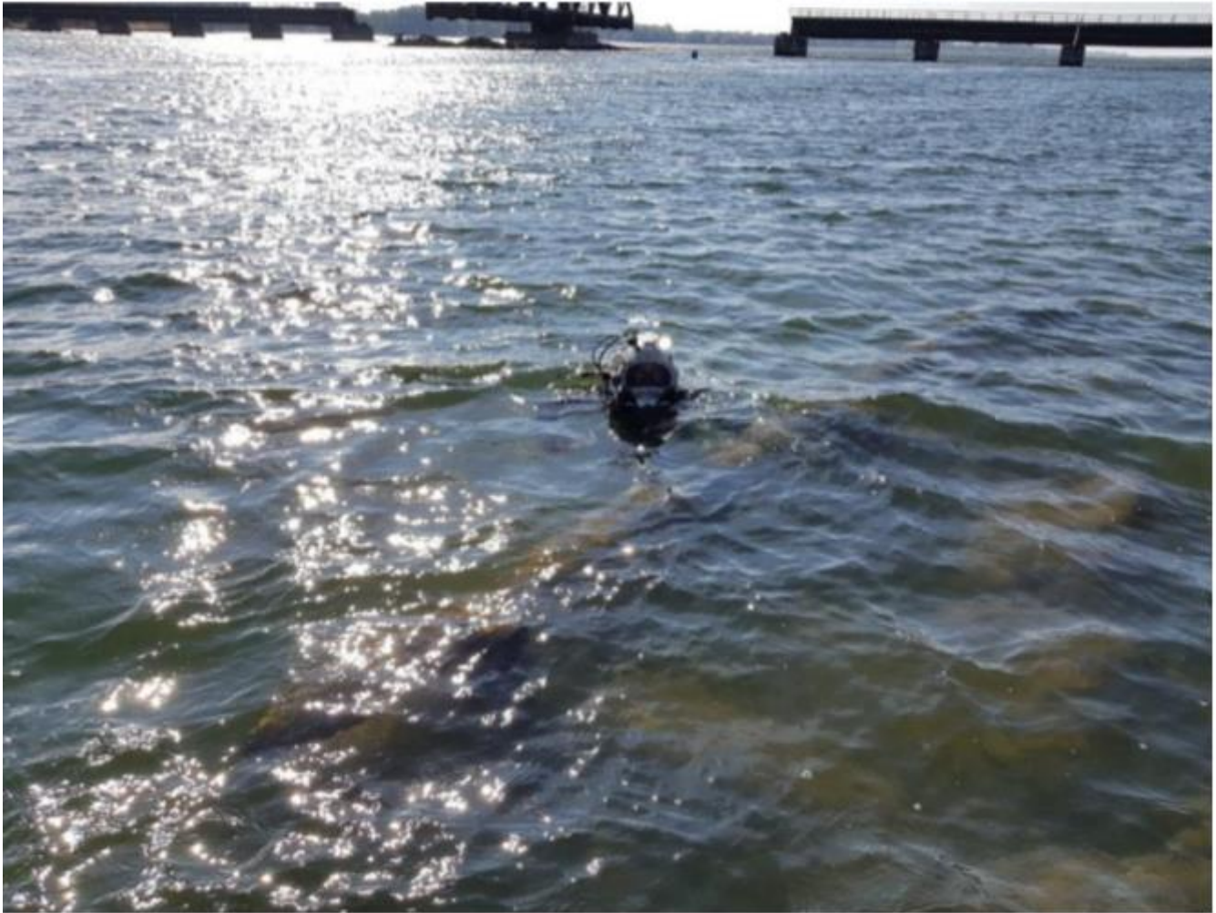
Encaissement de bois et enrochement de la conduite 1070 mm
