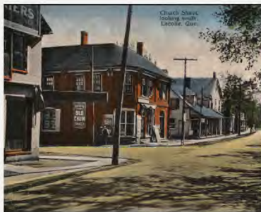
Rue de l'Église avec le Magasin Landry
